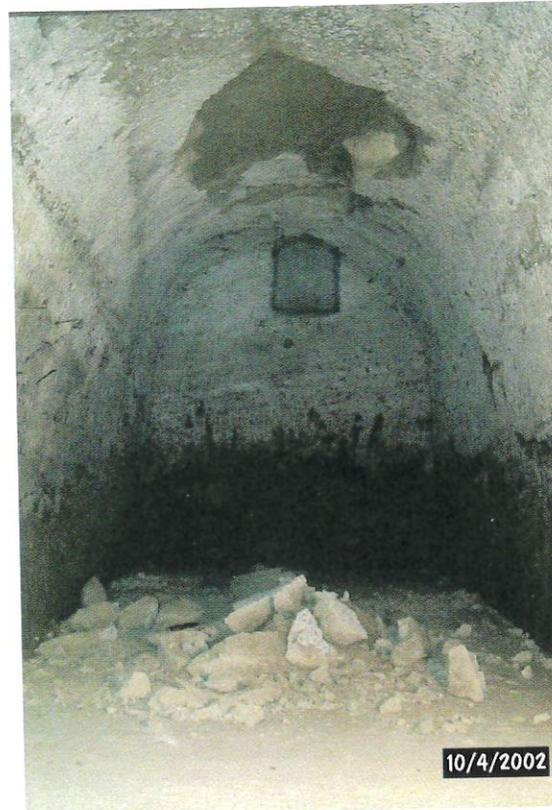
Foto 3. Melfi: crolli avvenuti in chiave alla cavità. Sul lato sinistro è possibile apprezzare la persistenza della frattura n. 5 di recente formazione.
